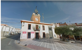
Figura 25. Vista frontal del Ayuntamiento de Almensilla (fuente: Google Earth)
