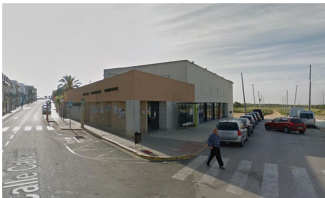
Figura 23. Imagen del edificio multifuncional del ayuntamiento de Almensilla (fuente: Google Earth)
