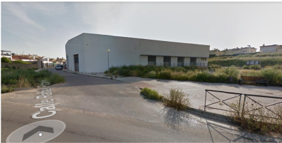
Figura 24. Imagen del edificio municipal dedicado uso de formación y empleo (fuente: Google Earth).
